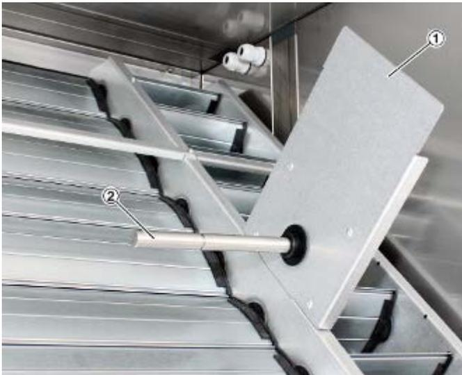
Abb. 19: H-Adapter mit waagerechte Antriebsachse
