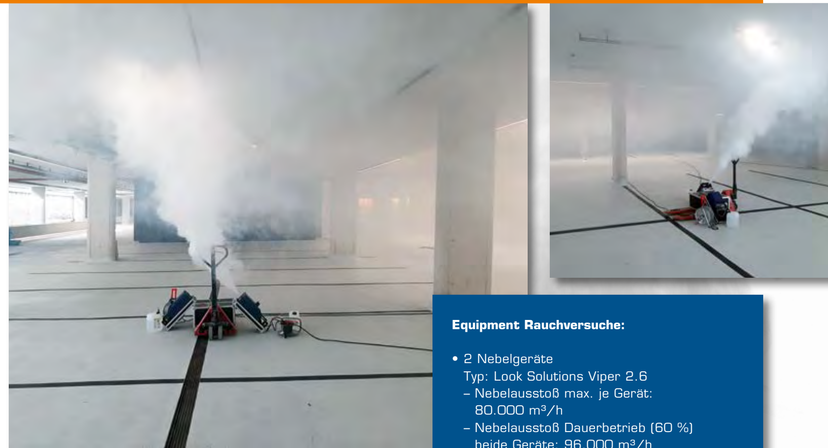
Rauchversuche mittels Nebelgeräten und teilweise unter Zusetzung zusätzlicher Temperatur durch Gasheizer.
