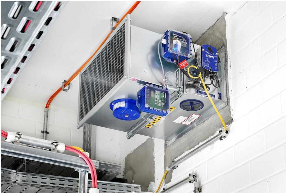
©TROX: Brandschutzklappe der Serie FK-EU als Überstromelement mit Rauchauslöseeinrichtung eingebunden in das TROXNETCOM System
