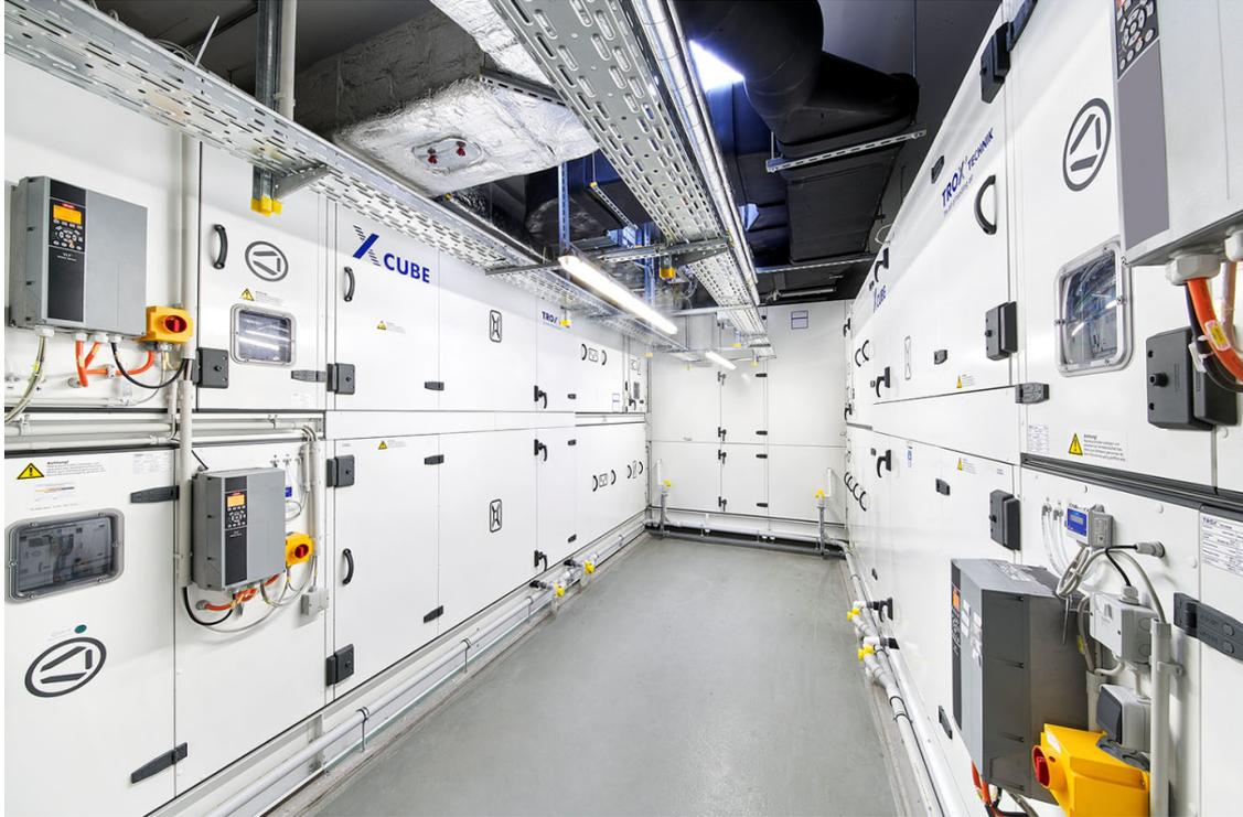
©TROX: X-CUBE- Gehäuse verwendet als isolierter Lüftungskanal
