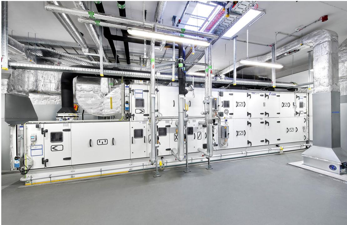
@TROX: Kombiniertes Zu- und Ablaufgeräte der Serie X-CUBE (einer von 51 X-CUBEs)
